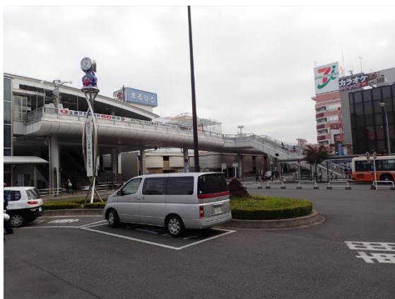
○上尾駅西口ペデストリアンデッキ
