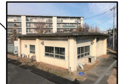
原市ポンプ場
