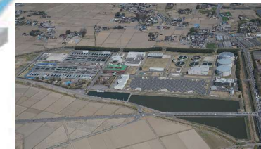
行田浄水場 (埼玉県企業局写真提供)
