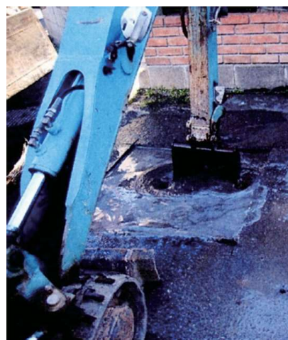
漏水修繕当番店による修理状況
