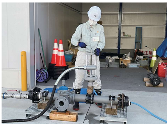
＜水道管分岐作業（φ50）＞
