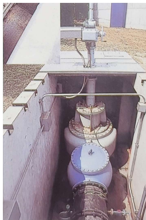
県水受水流量计(東部浄水場)
