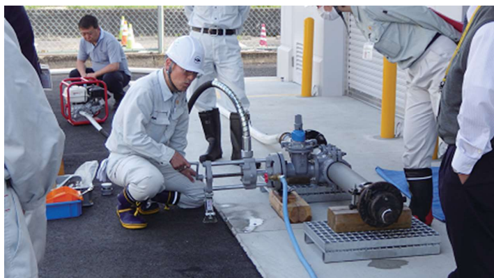
＜水道管分岐作業（φ75）＞
