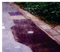
新しいタイプの弁きょうに交換
