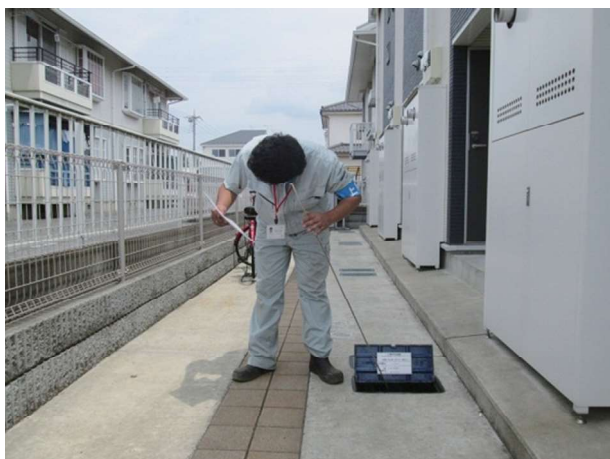
音聴棒による給水装置戸別音聴調査作業
