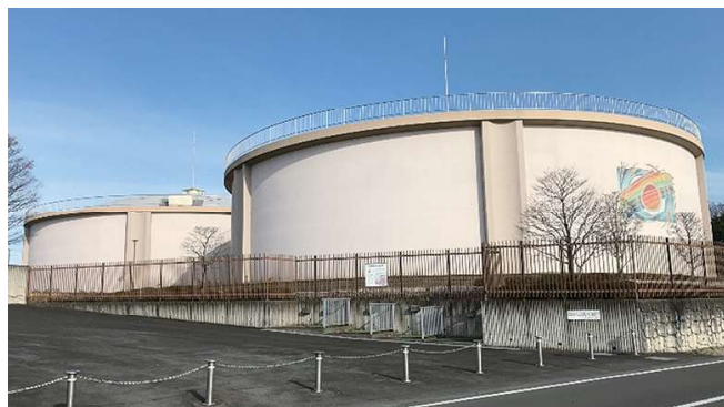
北部浄水場 配水池（PC造）
