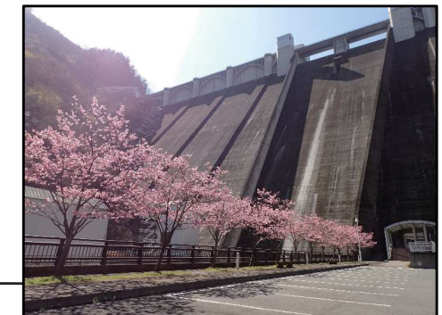
浦山ダム(水資源機構写真提供)
