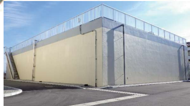
着水井・混和池
