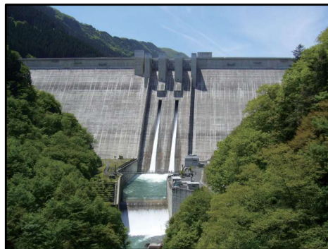
滝沢ダム(水資源機構写真提供)
