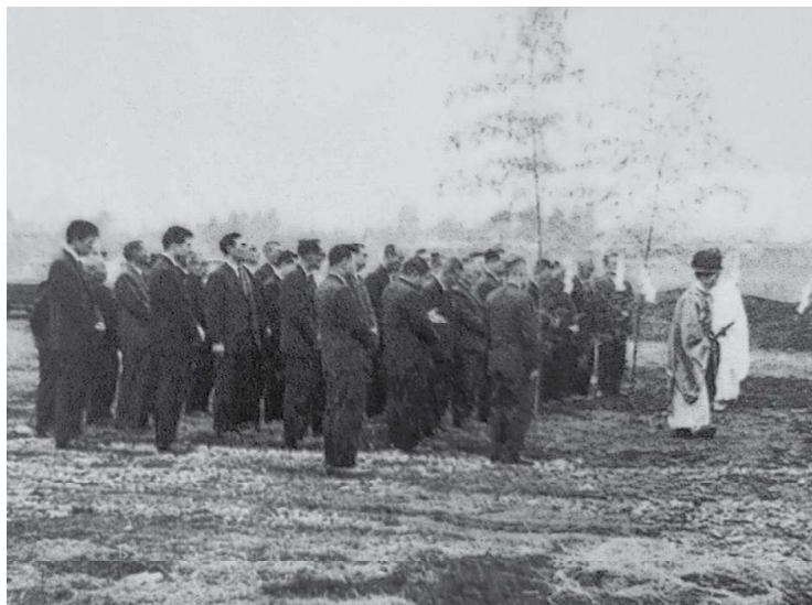
中央浄水場起工式
