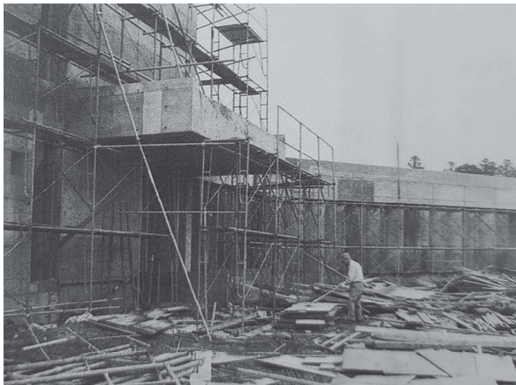
北部浄水場建設工事
