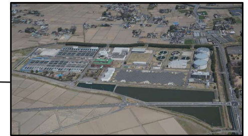
行田浄水場(埼玉県企業局写真提供)
