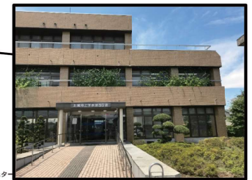
上下水道部庁舎
