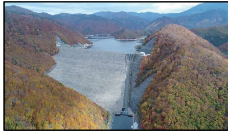
奈良俣ダム(水資源機構写真提供)
