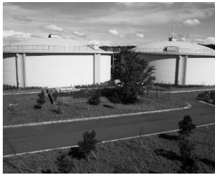
昭和39年給水開始の上尾市水道事業 (写真は北部浄水場)
