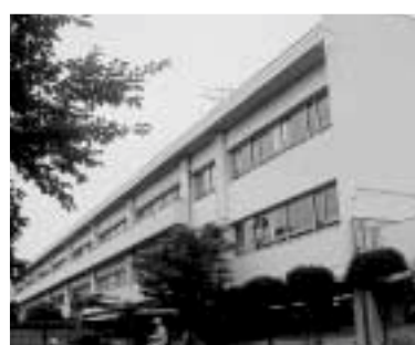
大規模改造工事が行われる尾山台小学校北校舎
