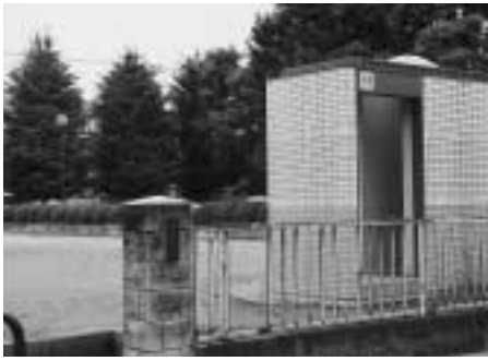
トイレが設置されている中妻第一公園
