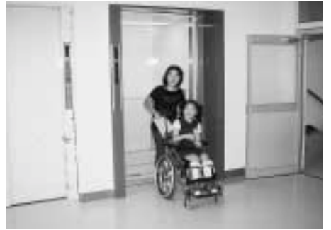
平方東小学校内に設置されたエレベーター
