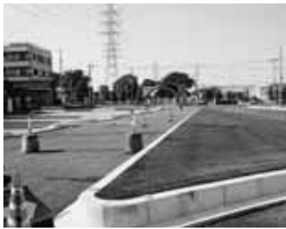
県道上尾環状線まで工事が進んだ第二産業道路
